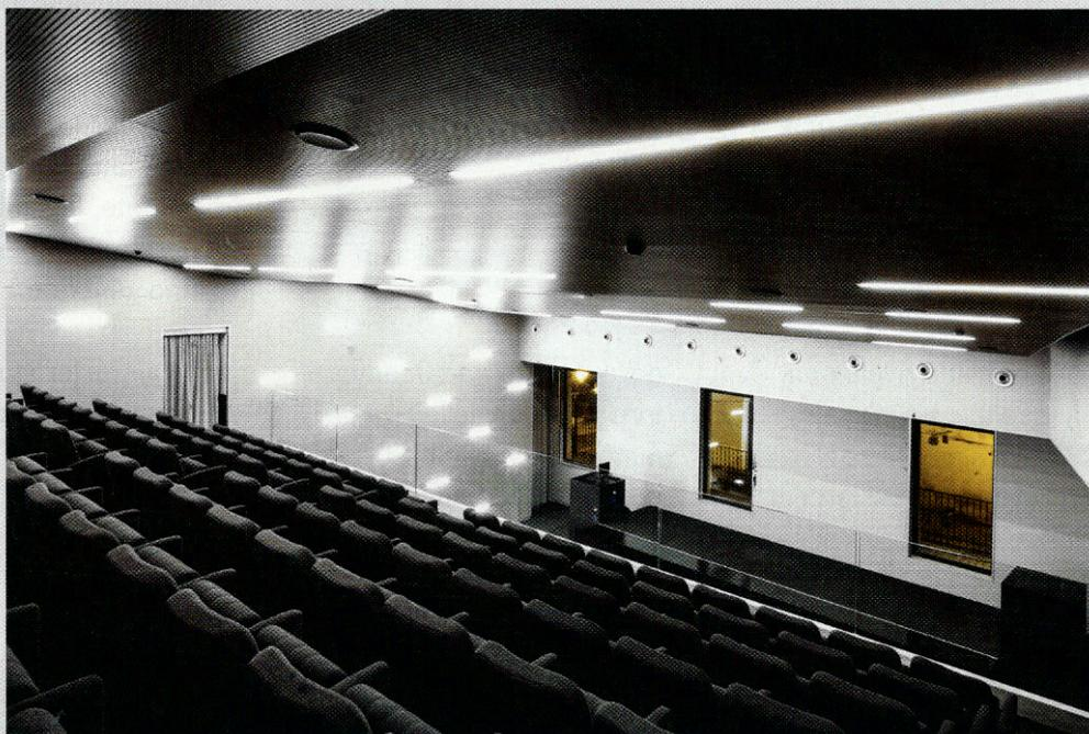
altezze e delle curve sonore, lungo le pareti. Il controsoffitto, che integra tutte le dotazioni impiantistiche della sala, già nel suo disegno asseconda la diffusione delle onde sonore. Esso è stato rivestito con dei pannelli fono-isolanti.
