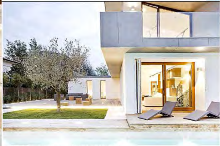
La fachada se funde con el contexto a través de color y materialidad.
